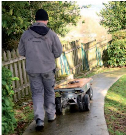
Dans le cadre de travaux de marbrerie en cimetière, dont notamment la pose de monuments funéraires, ou de columbariums, l'entreprise Mérigot s'est équipée d'un chariot-porteur radiocommandé électrique Hydro-system, d'une capacité maximale de 1,6 tonne. Ici, pose d'un columbarium avec accès limité pour les véhicules.
